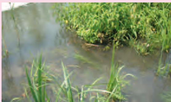
Esempio di fitodepurazione nelle Valli del Mincio: ingresso e uscita delle acque prima e dopo il trattamento.
