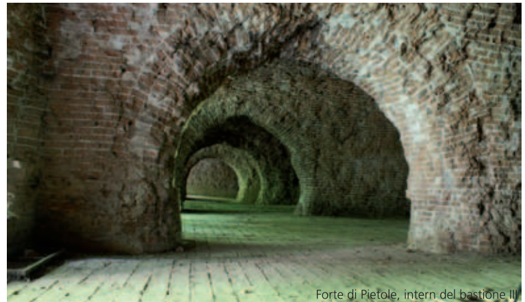
Forte di Pietole, intern del bastione III
